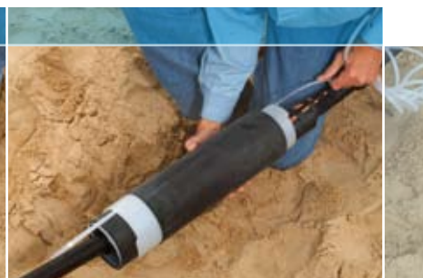
Smrštění vnější ochranné trubice
