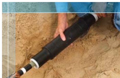
Nasazení vnitřní trubice
