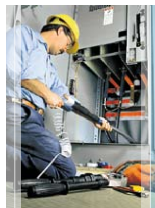
Montáž staniční koncovky
